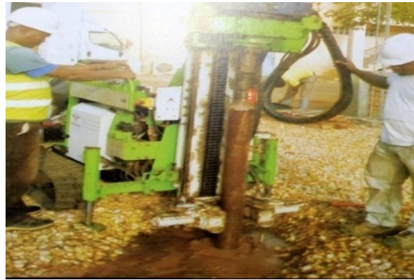
Figure 3.23: Essai au Pénétrömètre dynamique
