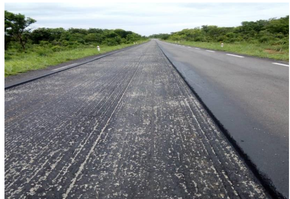
Figure 3.7: Reprise de la couche de roulement (voie de contournement Alédjo Juin 2018)
