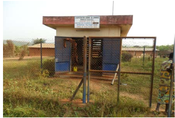
Photo N°7 : Forage équipé de pompe électrique
