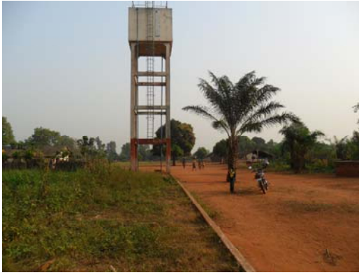
Photo N°6 : Réservoir d'une AEV immergée,
