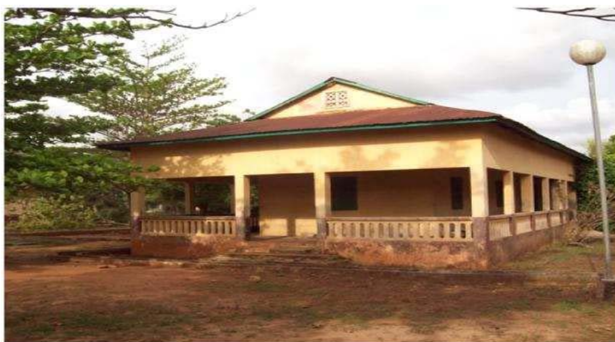
Photo 2 : Bâtiment ancien d'hospitalisation de la Chirurgie Source : Cliché DEGUENON 2012
