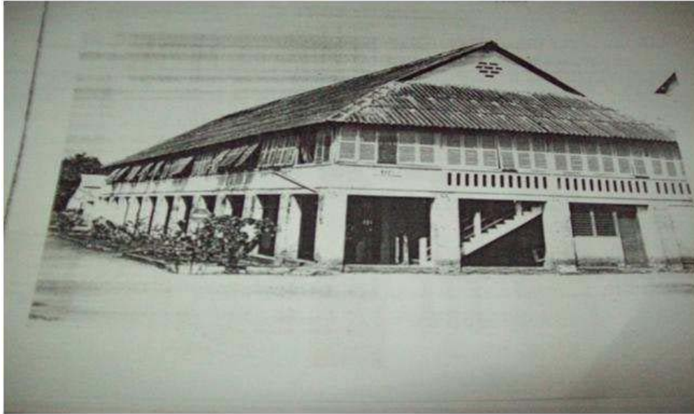
Photo 1 : Hôpital de Porto-Novo dans sa première architecture, début xix ème siècle Source : Reproduction d'Alain SINOUE et OLOUDE 2004
