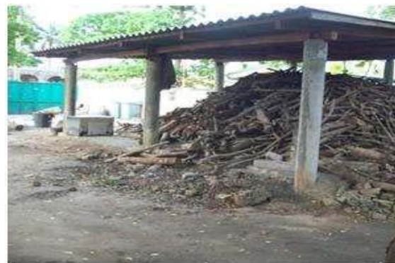
Photo 6 : Espace "bois de chauffage" : un hangar abrite ces bois obtenus par l'abattage de quelques arbres de l'hôpital Source : Cliché de DEGUENON, 2012
