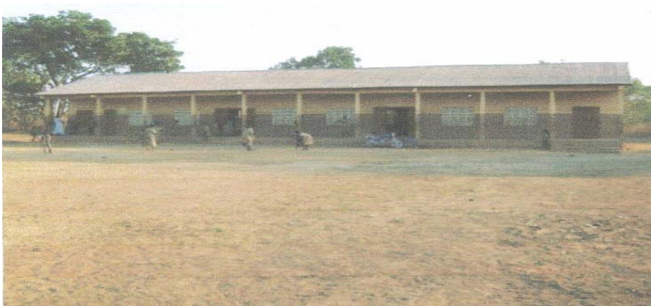
Photo 1: Ecole moderne construite selon les normes Ecole de Qualité Fondamentale (EQF) dans la localité d'Ina - BEMBEREKE.
