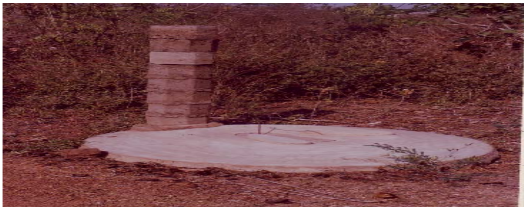
Photo O : Latrine inutilisable (Village de Madankanmè) Arrondissement de MADRE/Commune de DOGBO
