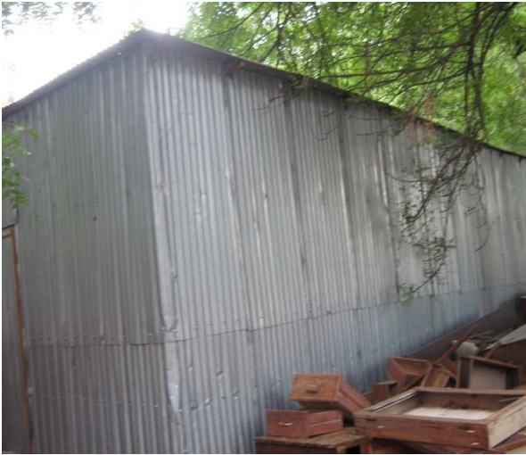
Baraque utilisée comme lieu de stockage des archives et des scellés
