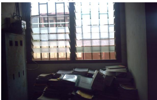
Figure 5 : Documents entreposés sous les fenêtres
