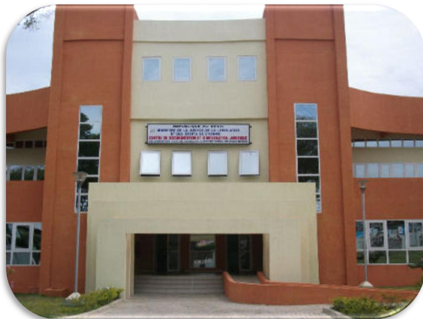
Photo 1 : Façade du Centre de Documentation et d'Information Juridique du Bénin (CDIJ)
