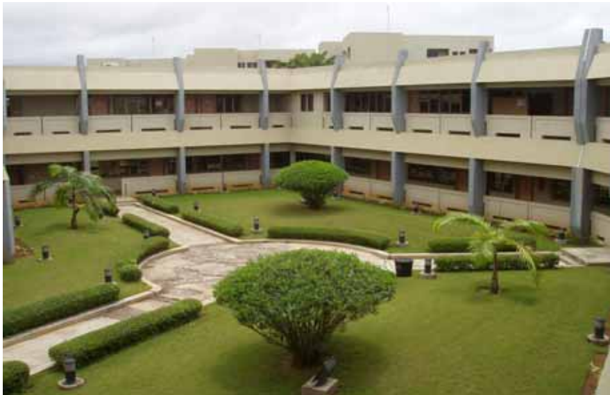
Photo 1 : Vue extérieure du CDI situé au rez-de-chaussée.
