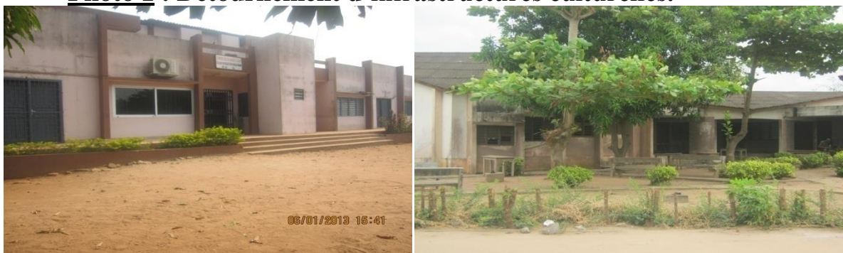
Bâtiment abritant le RFU et le service des Sapeurs pompiers d'AC
