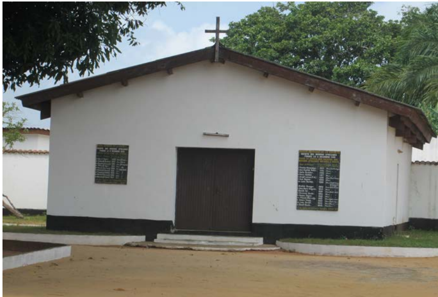
Figure 6 : Bâtiment consacré à l'exposition temporaire. Source : Tatiana ALLAGBE
