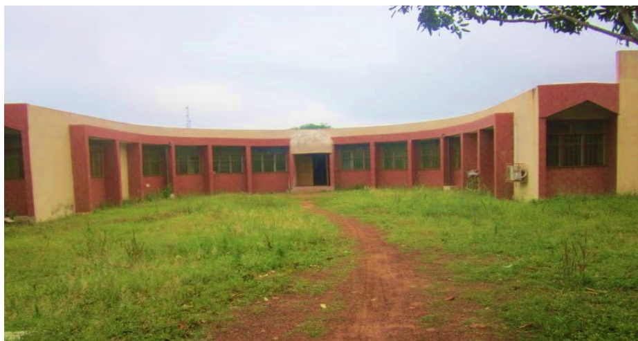
Figure 11 : Devanture de la Maison Internationale du Gèlèdè Source : Eunice Zounon, Septembre 2014
