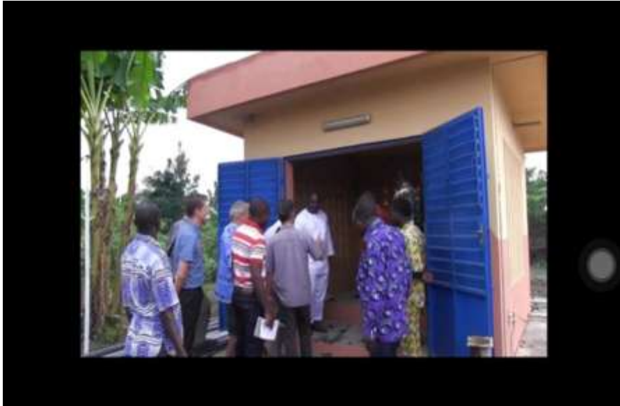
Photo no 5 : L'abri générateur du réseau d'adduction d'eau potable
