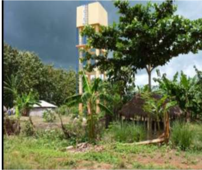
Photo 2 : Château d'eau du réseau d'adduction d'eau potable
