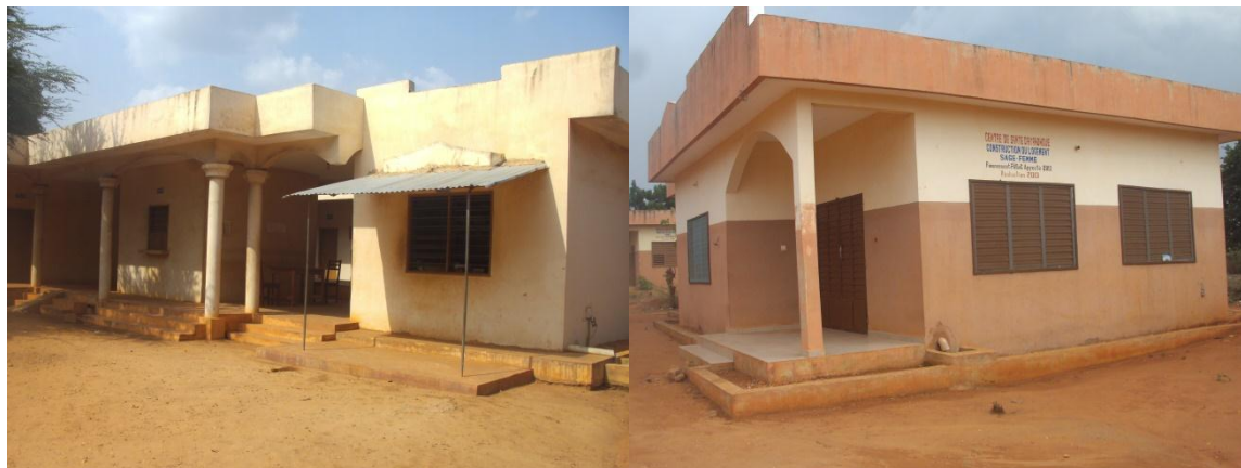
Planche 2 : Logement de sage-femme au CS Ayahohoué et bloc administratif au CSU
