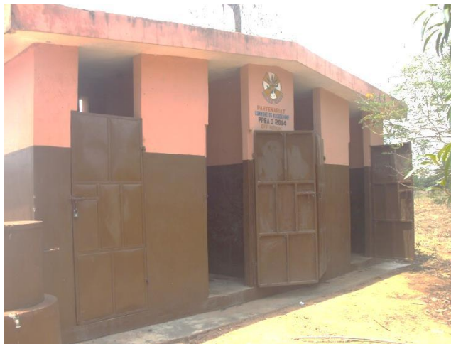
Photo 8 : Construction d'une latrine à l'EPP Kédji Prise de vue : Etou, août 2016
