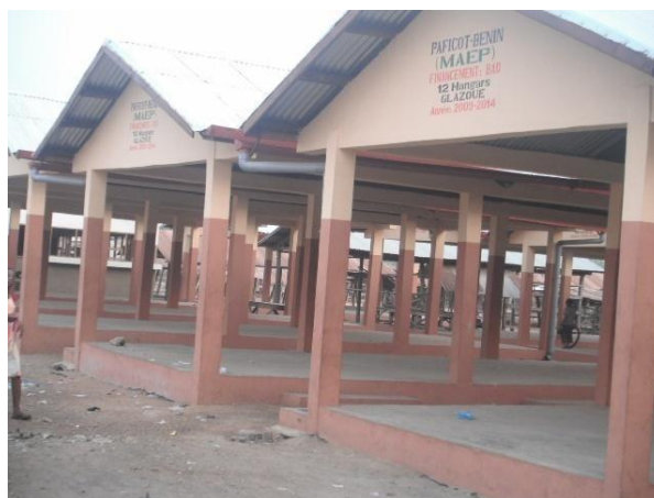
Photo 1: Infrastructure marchande du marché principale de Houndjlo
