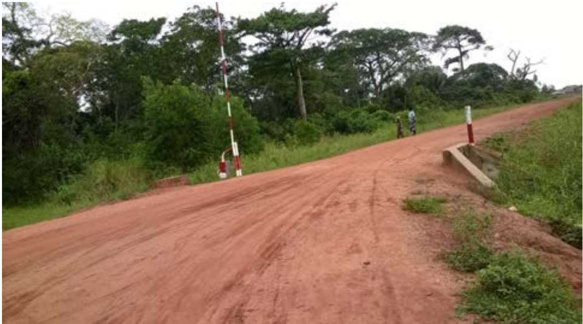
Photo 7 : Voie recouverte de latérite reliant les arrondissements d'Avagbodji et des Aguégus, aménagée par les organisateurs de "Wémexwé". Prise de vue : Aklamavo (septembre 2015)
