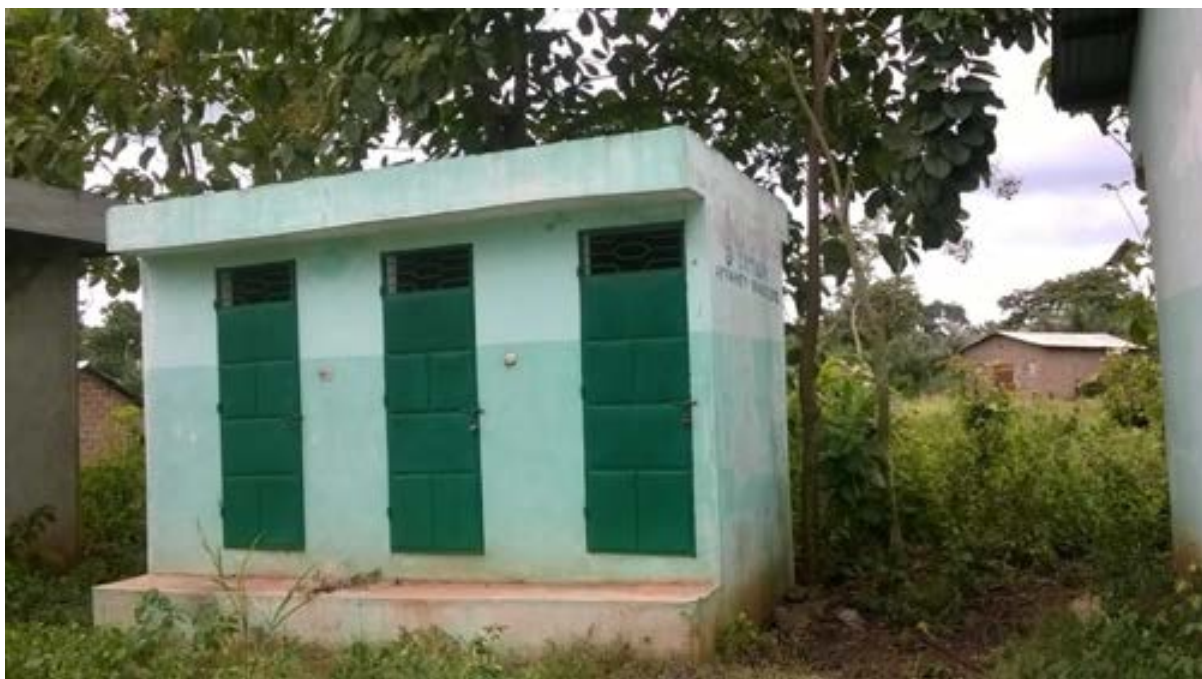
Photo 10 : Une latrine à trois cabines construite par les organisateurs de “Wémexwé” au CEG d’Affamey.
