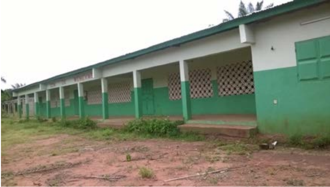
Photo 6 : Un module de trois classes avec bureau de direction, construits par les organisateurs de "Wémexwé" au CEG de Goutin. Prise de vue : Aklamavo (septembre 2015)
