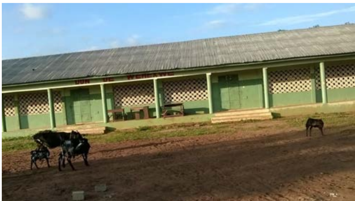
Photo 11 : Un module de trois classes entièrement équipées au CEG 2 de Dangbo, construites par les organisateurs de “Wémexwé”
