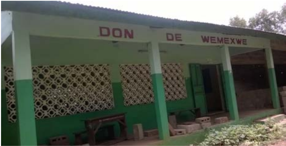
Photo 4 : Une salle de classe construite par les organisateurs de “Wémexwé” au CEG d’Adjohoun.
