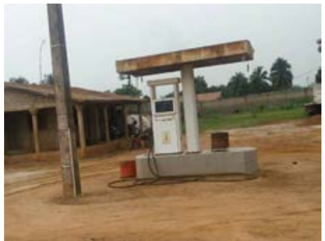
Photo 10 : Implantation d'une station service aux abords de la RNIE 2 à Sékou
