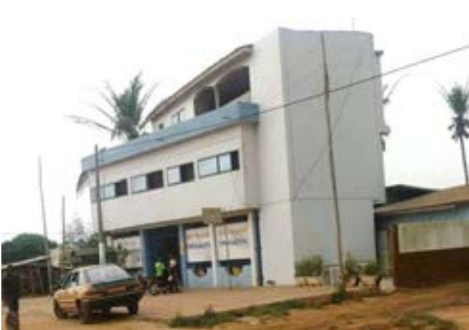
Photo 9 : Installation d'un bâtiment de type R+ 2 avec revêtement en carreaux servant de buvette aux abords de la RNIE 2 à Sékou
