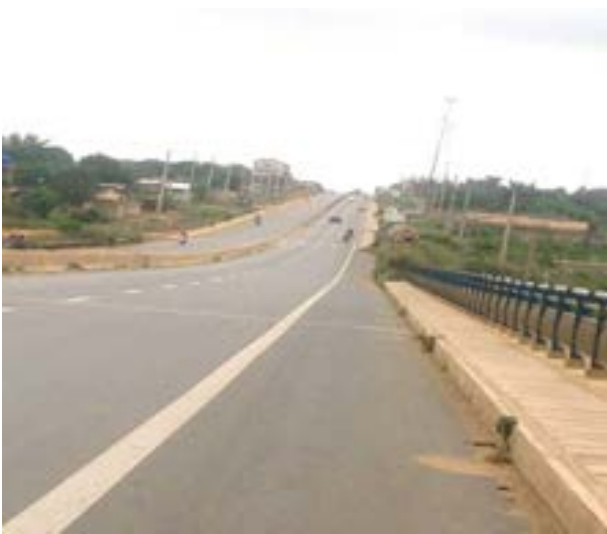
Photo 7 : Aperçu de la RNIE2 double voie sur le pont d'Allada
