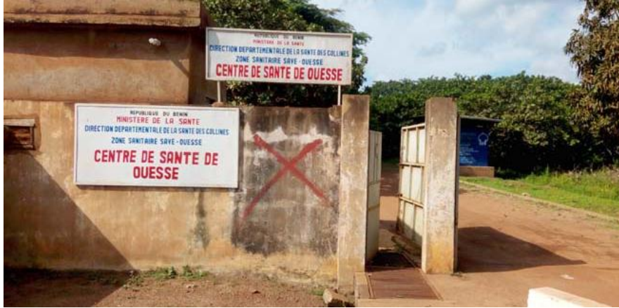
Photo 1: Centre de santé de la commune de Ouessè Prise de vue : YAÏ, septembre 2018
