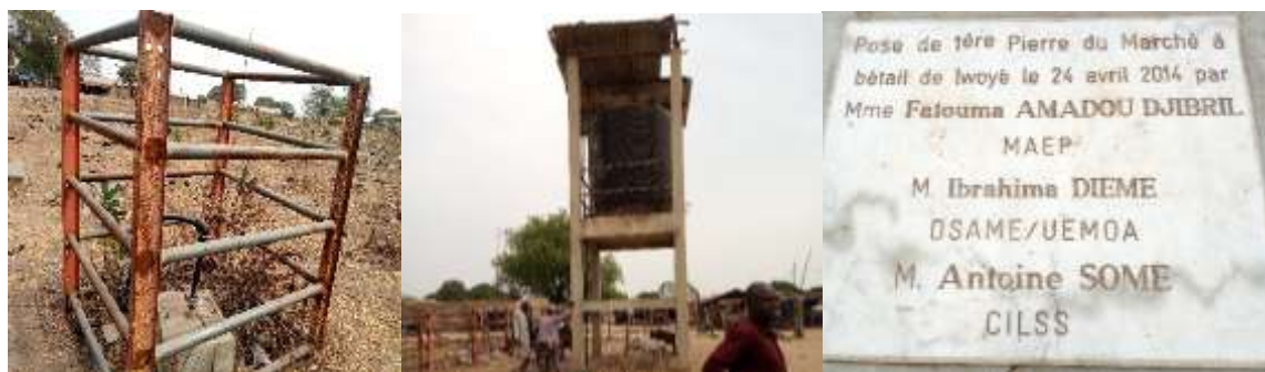
Planche 2 : Forage réalisé par UEMOA au marché à bétail de Iwoyé
