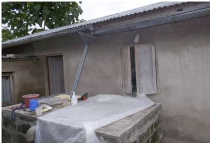
Photo 2 : Système de recueillement d'eau potable de pluie à Toffo Prise de vue : Codo, octobre 2018
