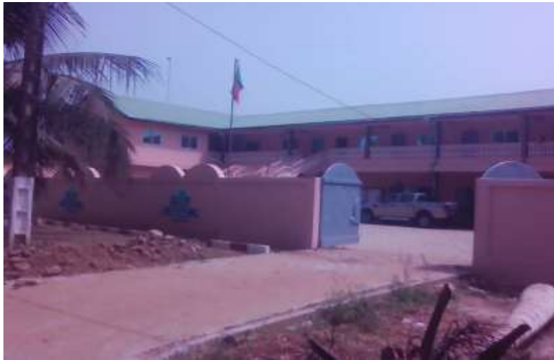
Photo 2 : Nouveau bâtiment de la mairie Prise de vue : Gbegnon, octobre 2018
