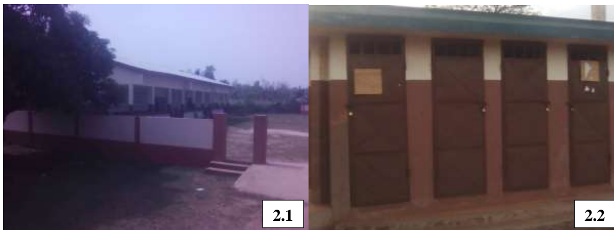
Planche 2: Infrastructures scolaires réalisées à Zounhouè (2.1) et latrine (2.2) Prises de vue : Gbegnon, octobre 2018
