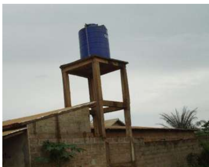
Photo 6: Exemple d'un Poste d'Eau Autonome Privé dans l'arrondissement de Sèhouè Prise de vue : Tchibozo, Juillet 2018,
