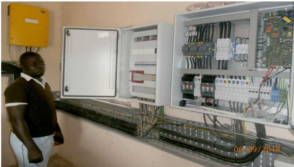
Photo 2: Coffret électrique de la mini-centrale solaire de Kabo
