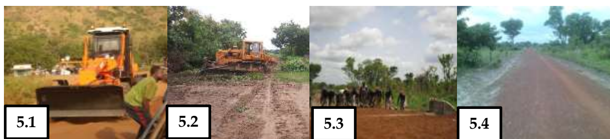
Planche 5 : réalisations dans le secteur piste rurale Prise de vue : AHOSSI, Août 2018
