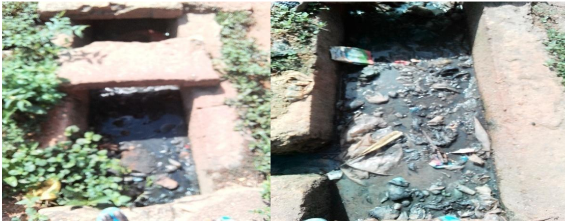
Photo 15 : Caniveaux ouverts non curés du marché Central
