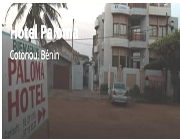
Photo 2 : Vue de face de Paloma Hîotel Prise de vue : Hounguèvou, Novembre 2018
