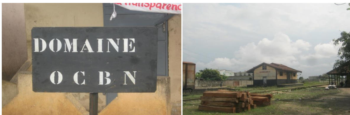
Cette plaque de l'OCBN devant le marché de Godomey-gare et ce bâtiment derrière le marché se veulent être le symbole de la propriété de l'OCBN sur le domaine où le marché est construit.
