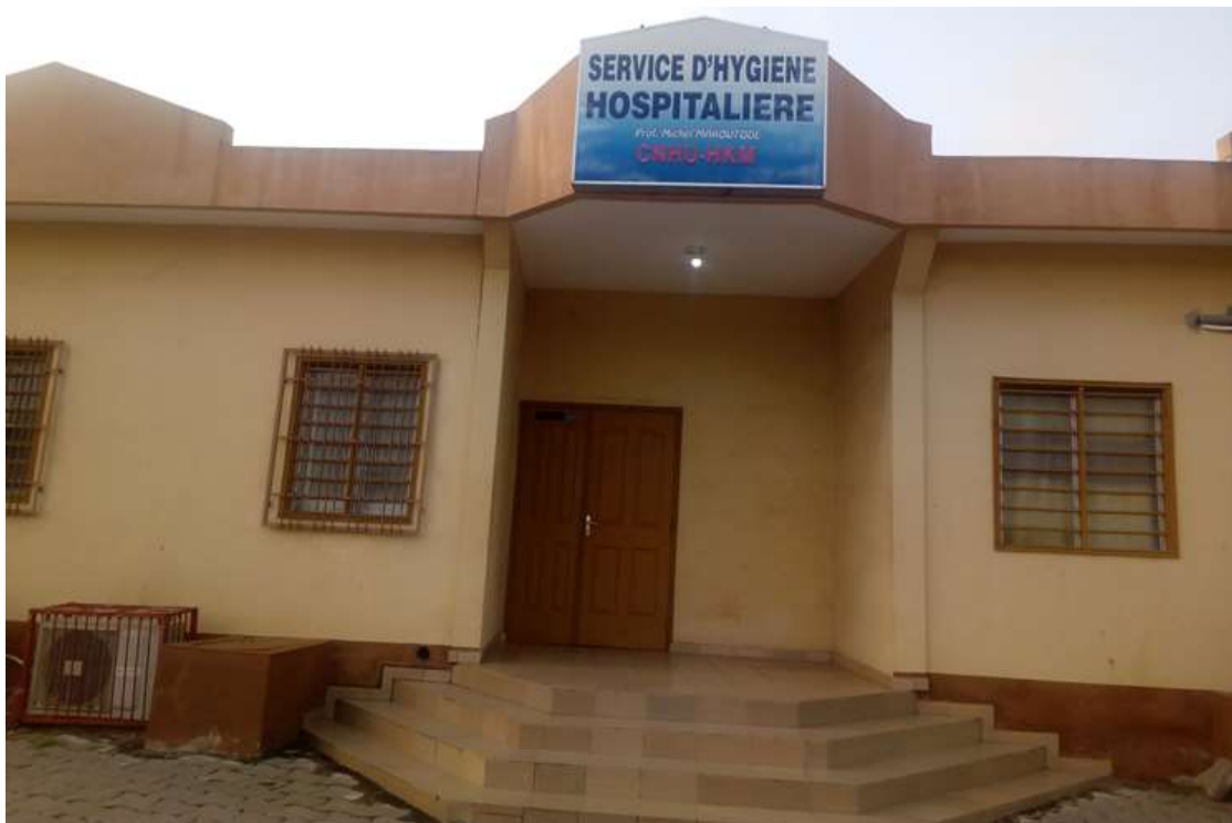
Photo 2 : Façade du Service d'Hygiène Hospitalière
