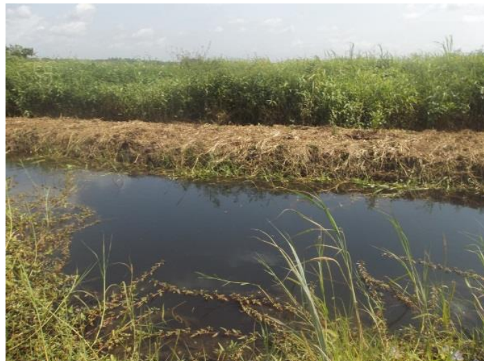
Photo 2: Digues contre l'inondation dans la Commune de Dangbo Prise de vue : Agbalessi, novembre 2016
