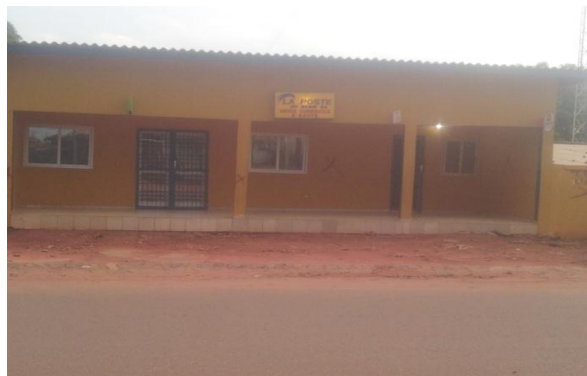
Photo 4: Vue partielle de la poste à Azovè
