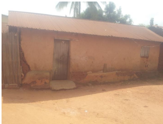
Photo 6 construction de type semi-traditionnel dans l'Arrondissement Azovè
