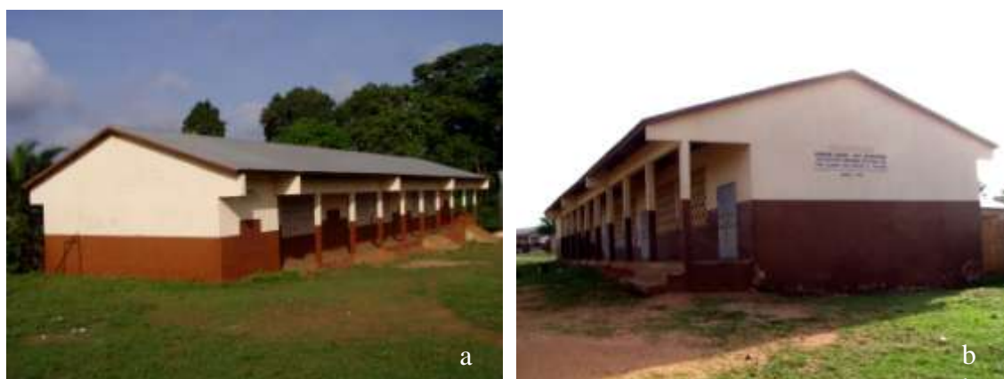
Planche 1 : Construction de salles de classe plus magasin à Kissawe et à Houin-Tokpa
