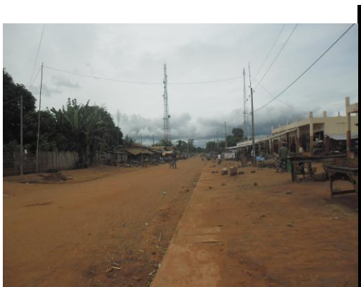
Photo 3: Infrastructure routière aménagée en latérite dans la Commune de Zè
