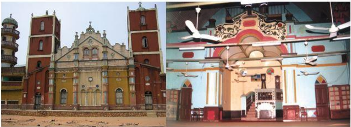
Planche 2 : Vue sur la façade Est de la Mosquée et aspect intérieur Photos EPA, 2005
