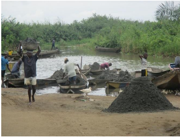
Photo n° 5 : Extraction du sable lagunaire AVAKPA
