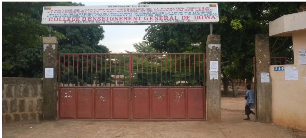
Photo 1 : Entrée principal du CEG de DOWA
