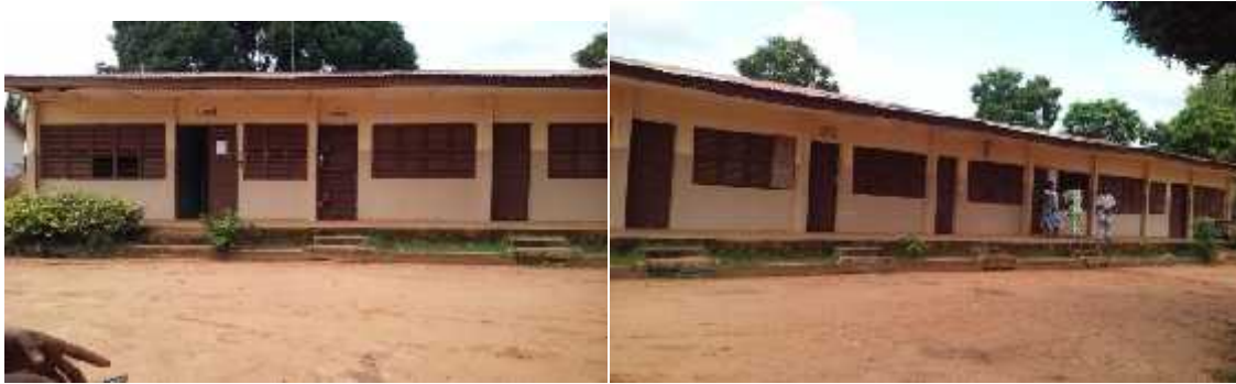
Planche2 : Bloc administratif du CEG de Djassin
