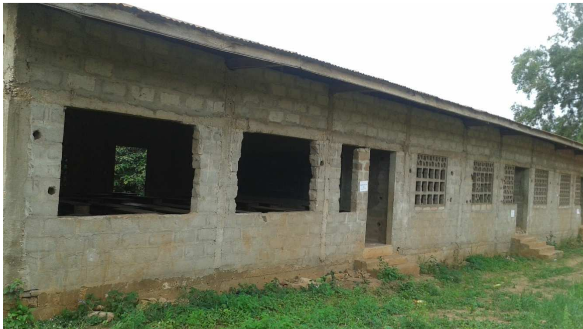
Photo n°1: Bâtiment en construction mais inachevé au CEG de Agbokou
