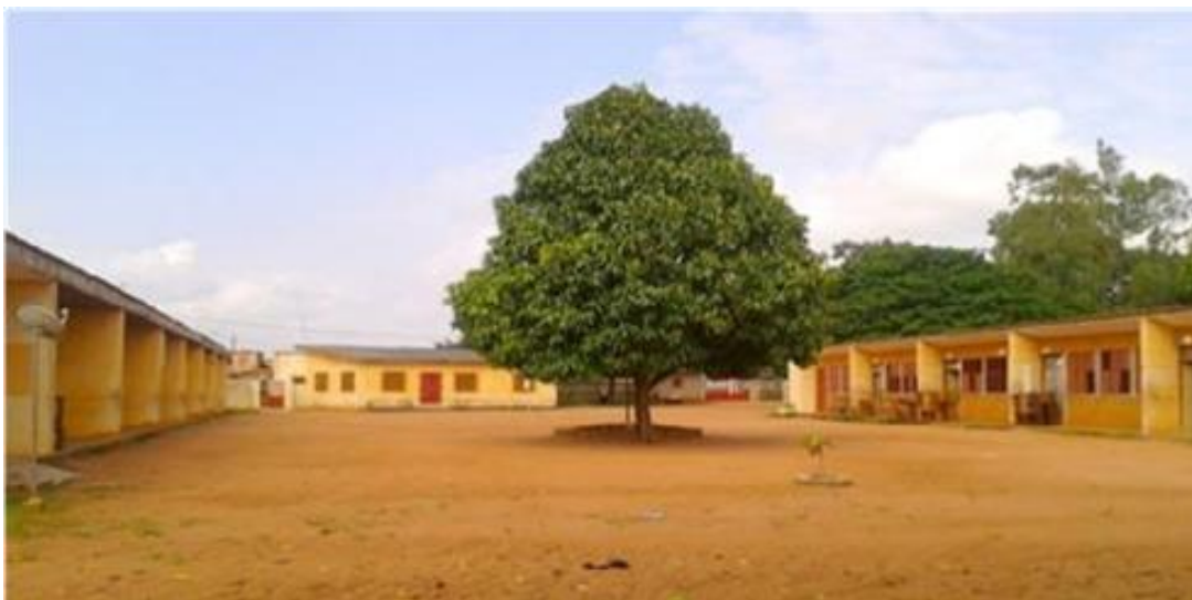
Photo 1 : vue sur la grande cour centrale du CEG d'Application
