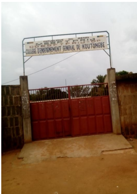
Photo 1 : Entrée principale du CEG de Koutongbé Prise de vue : Gérardine DJIDONOU, juillet 2016
