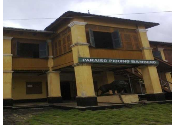
Photo n°2 : Façade principale du bâtiment de PARAISO PIQUINO BAMBERO à Porto-Novo, architecture Afro-Bésilienne
