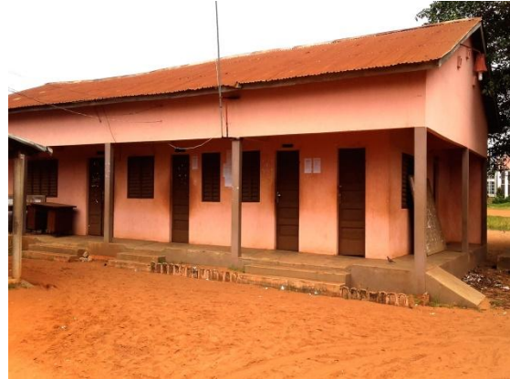
Photo n°6 : Bâtiment de services surveillance générale, censurat et salle des professeurs. Prise de vue : SOARES F., août, 2016
