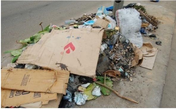
Photo n°1 : aspect physique du terre-plein central longeant la double-voie du carrefour « Commissariat central » à la grande mosquée de Zongo.
