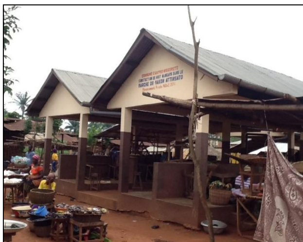
Photo 8 : Hangars construits par la mairie construites dans l'arrondissement de Vakon
