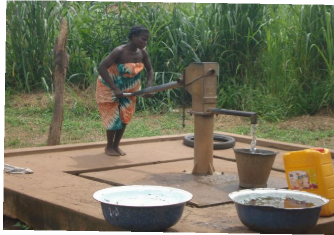
Photo 3 : Pompe à motricité humaine à Hounli Prise de vue : Honvo, mai 2017
