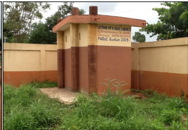
Photo 5 : Latrine à deux cabines construites à Vakon
