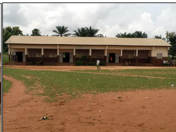
Photo 2 : Vue partielle d'un module de classe construit à l'EPP de Vakon
