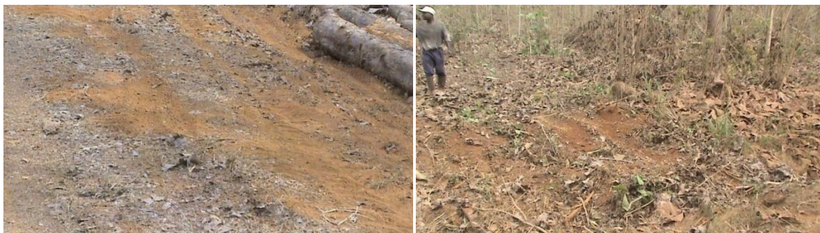
Photo 19: Piste principale décapée lors de l'empilage des grumes Photo 20: Etat d'un sol décapé au cours des opérations de débardage
