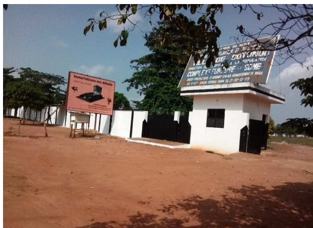
Photo 13 : Entrée principale du site du cimetière de Somè
