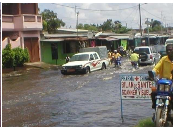
Photo 2 : Etat de certaines voies en période d'inondation à Cotonou (Tronçon Ste Rita- Fifadji), juin, 2010
