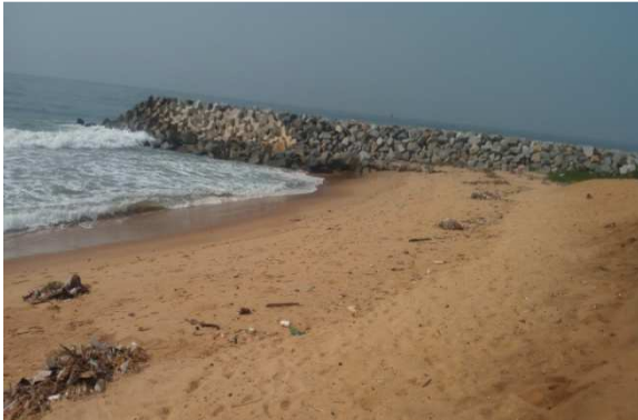
Photo 3 : Epis de protection de protection à l'Est du Port
