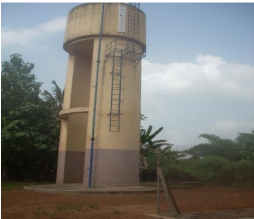
Photo 2 : Château d'eau à Agbodjèdo (arrondissement de Tangbo) C'est le seul château qui alimente les bornes fontaines dans ce village Cliché : Ehoulo 2012
