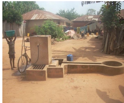
Photo 3 : Borne Fontaine à Agbodjèdo (arrondissement de Tangbo) C'est l'une des bornes fontaines reliée au château se trouvant à Aïdjèdo Cliché : Ehoulo 2012
