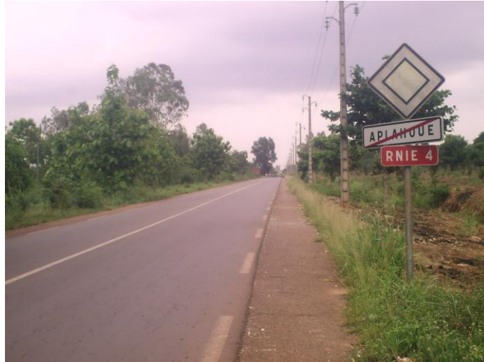
Photo 1 : RNIE 4 à la sortie nord d’Aplahoué
