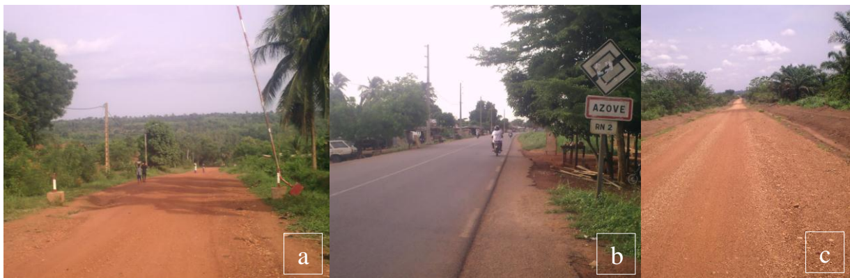
Planche 1 : Etat des voies RN 2 (a), RN 2 bis (b) et RN 34 (c) d’Aplahoué
