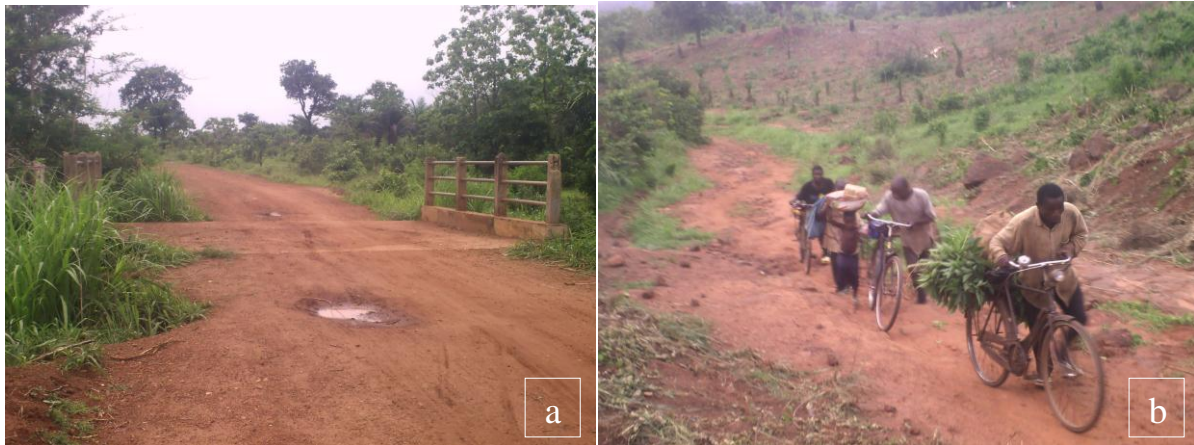
Planche 2 : Vues partielles de deux pistes de desserte d'Aplahoué
