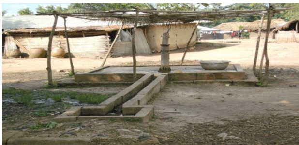
Photo 7 : Un Forage équipé de Pompe à Motricité humaine à Tohonou Prise de vue : KPEHOUNOU , Septembre 2014
