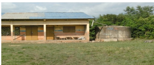
Photo 10 : Une citerne abandonnée à EPP Tohonou Prise de vue : KPEHOUNOU , Septembre 2014.
