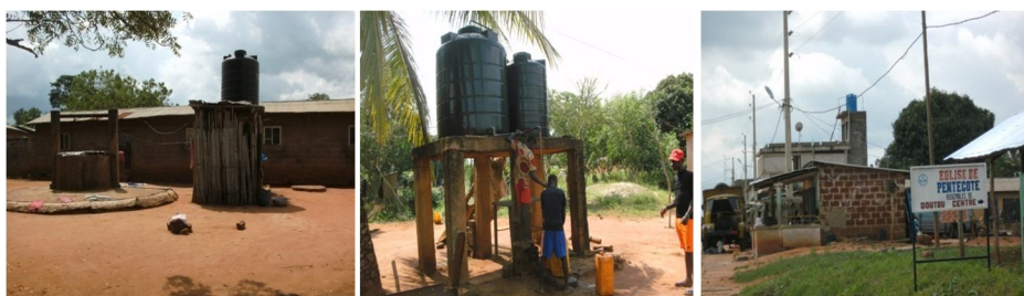
Planche 8: Postes d'Eau Autonome dans l'arrondissement de Doutou Prise de vue : KPEHOUNOU, Septembre 2014
