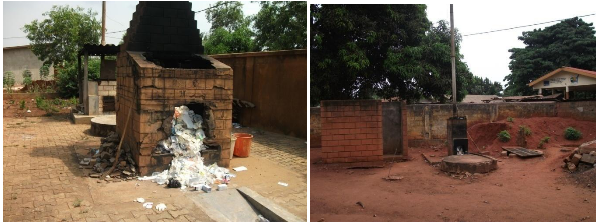
Photo 11: Incinérateur de l'Hôpital de Zone et de centre de santé de Comè.
