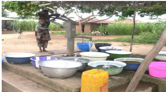
Photo 10: Ouvrage simple ; Forage équipé de pompe à motricité humaine
