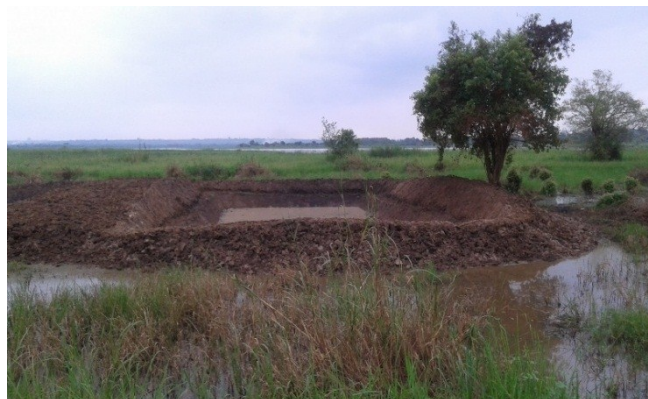
Photo 7 : Réalisation d'un ouvrage piscicole aux abords du lac Doukon. Prise de vue : AMOUZOU, 2015
