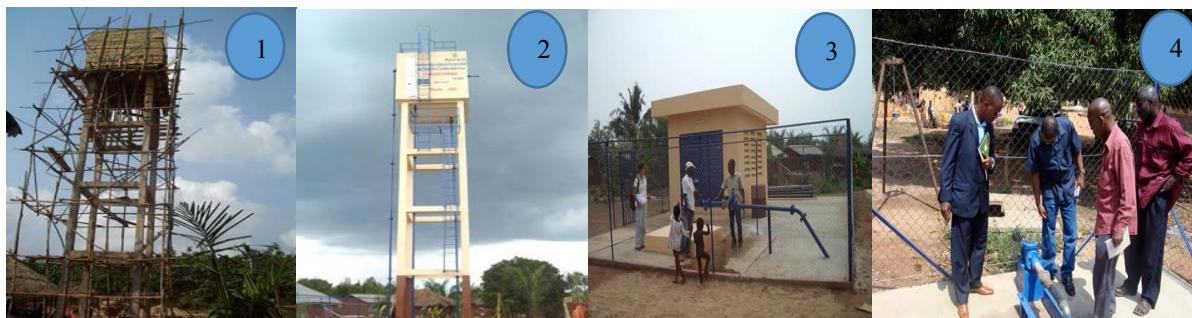
Photo 5 : 1 et 2 : réalisation de château d'eau ; 3 : Abri groupe et 4 : Tête de forage
