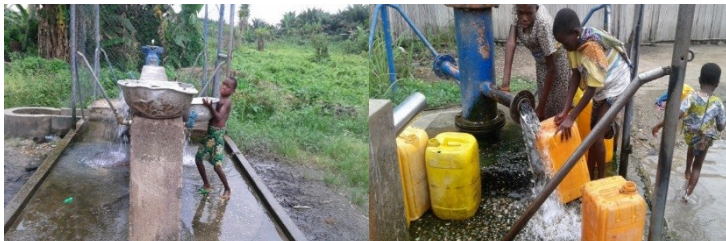
Photo 3 : Forages artésiens jaillissants dans différentes localités de Ouédèmè-Adja (Adjacomè et Kinwouédji). L'eau coule dans la nature créant des marres.
