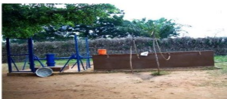
Photo 4 : Forage artésien de Logbo, aménagé en 2009.
