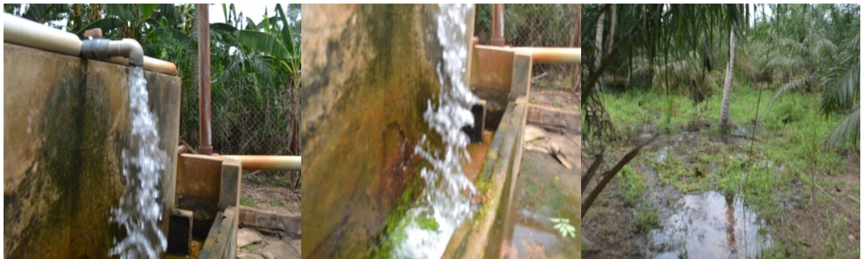
Photo 12 : Forage artésien jaillissant à Gnanwouihoué (Arrondissement de Koudo) juxtaposé de marre. Prise de vue : AMOUZOU, 2015
